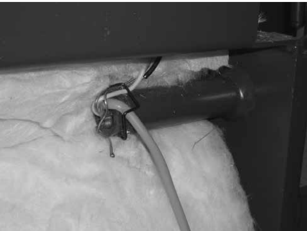
Obr. 15 - pohled na čidlo teploty vody TK v jímce kotle DCxxSP(X)/(EP), CxxSP, ACxxSP nebo kotle s hořákem ve vrchních dvířkách DCxxS(X), CxxS(T), ACxxS, KCxxS, DCxxRS
